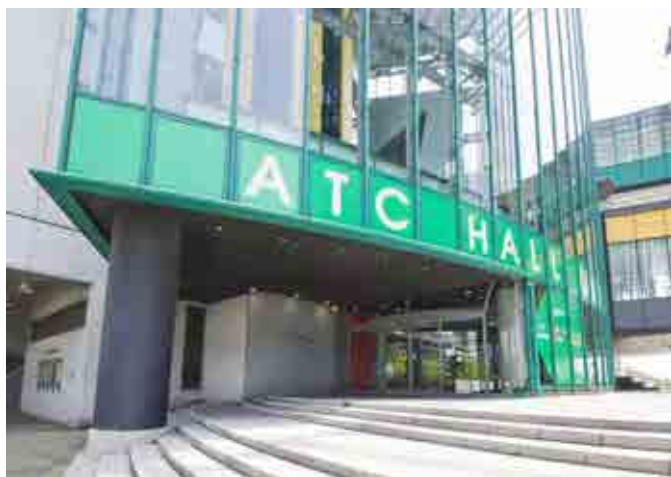
ATCホールエントランス
